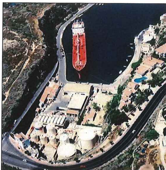
Imagen 2. Descarga de graneles líquidos en Cala Figuera.
