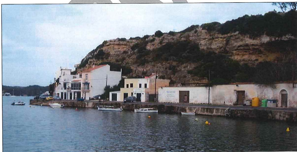
Imagen 4. Muelles verticales y edificaciones existentes en la zona de levante de la dársena de Cala Figueras.
