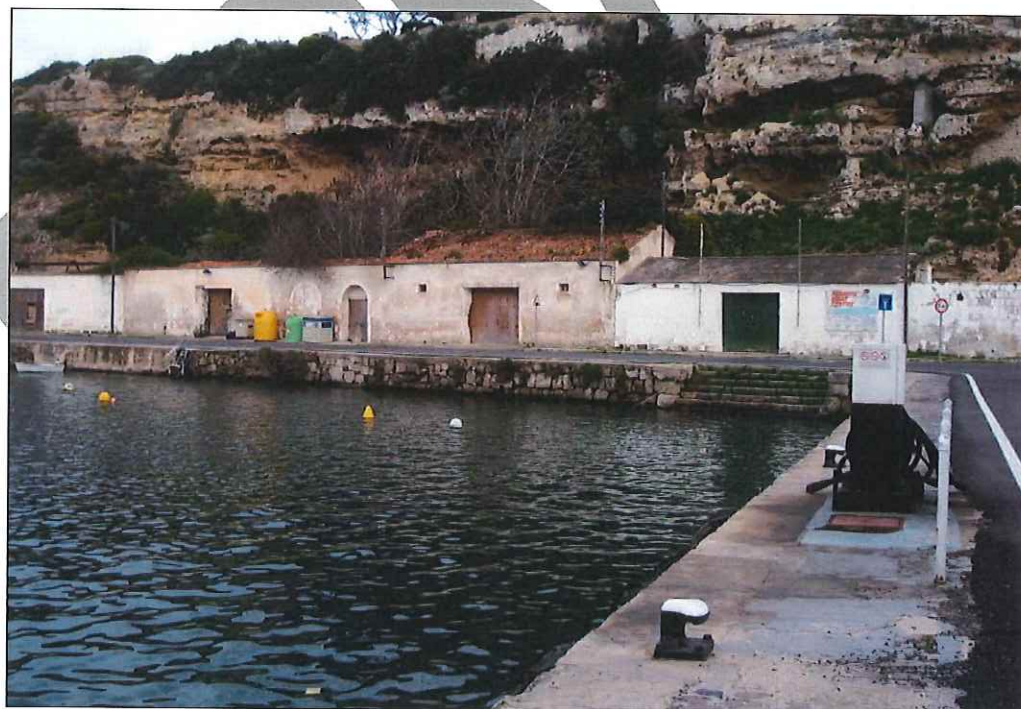
Imagen 10. Estado actual de las edificaciones y muros a demoler.
