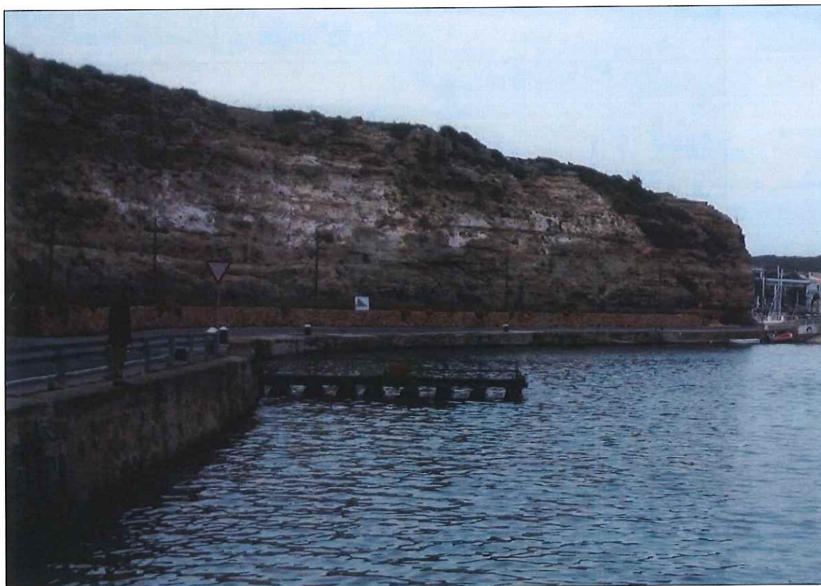
Imagen 3. Muelles verticales existentes en la zona de poniente de la dársena de Cala Figueras.
