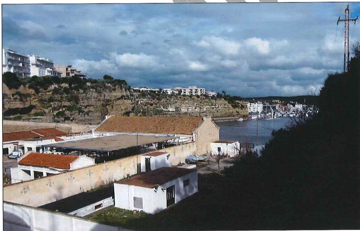
Imagen 7. Explanada de la estación de bombeo (primera línea) e instalaciones de CLH (al fondo).
