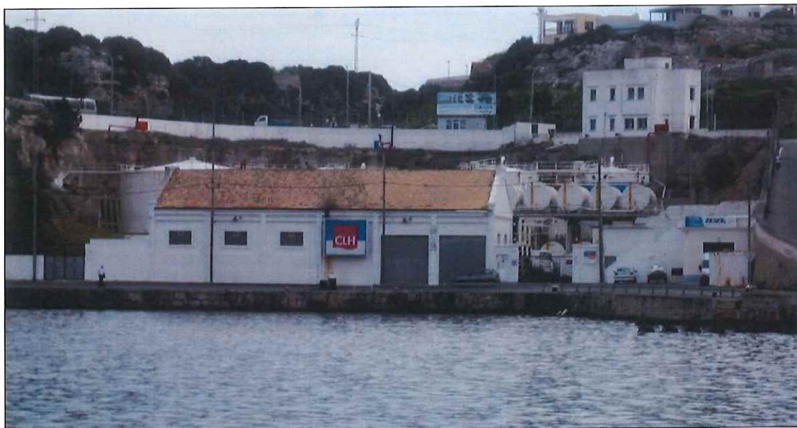
Imagen 6. Instalaciones de CLH de Cala Figuera (a la derecha) y explanada de la caseta de bombeo (a la izquierda).
