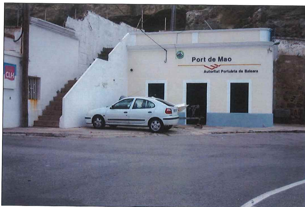
Imagen 8. Edificio de la Autoridad Portuaria de Baleares.
